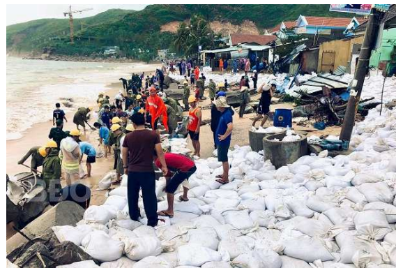
Hình 3.24.b. Khắc phục hậu quả sạt lở kè biển xã Nhơn Hải, Quy Nhơn (bão số 5 ngày 01/11/2019)
