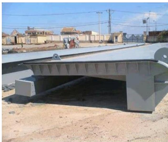
Hình 85. Đập tràn bố trí cửa van điều tiết trên đỉnh tràn [58]
