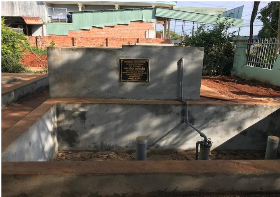
Hình 75. Mô hình giếng khoan khai thác kết hợp bổ sung nhân tạo cho nước dưới đất [5]
