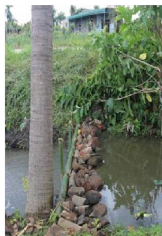
Hình 87. Đập ngăn dòng đã được triển khai trên Tây Nguyên bằng các vật liệu khác nhau [58]
