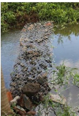
Hình 87. Đập ngăn dòng đã được triển khai trên Tây Nguyên bằng các vật liệu khác nhau [58]
