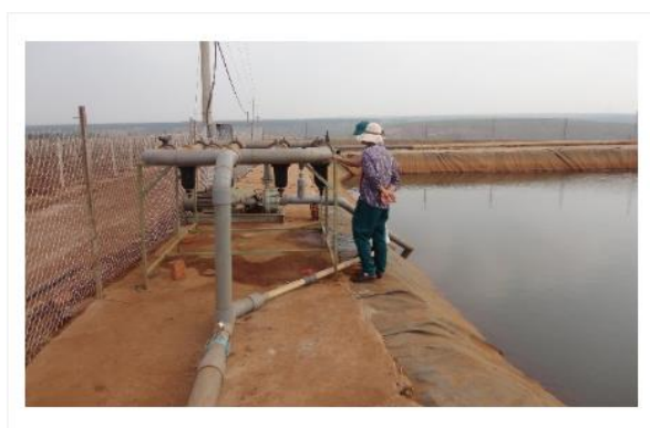
Hình 80. Hệ thống tưới nước nhỏ giọt Israrel cho cây cà phê
