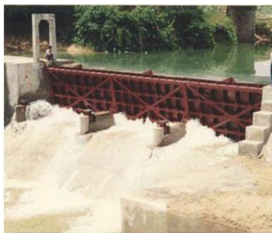
Hình 85. Đập tràn bố trí cửa van điều tiết trên đỉnh tràn [58]
