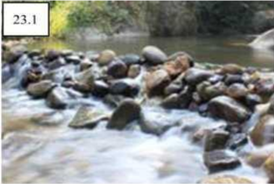
Check dam dùng vật liệu đá xếp; đá trát vữa
