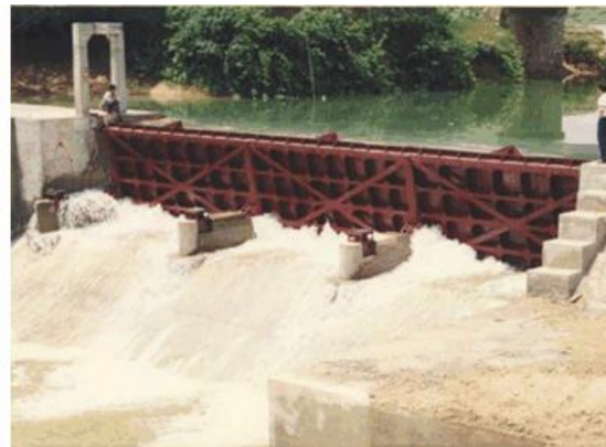
Cửa van tự động lật trục ngang 16x4m
