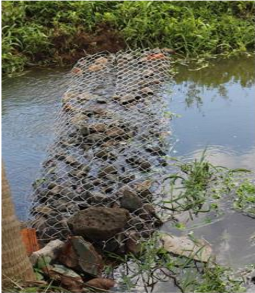
Hình 5.37. Check dam làm từ vật liệu lưới thép trong bọc đá
