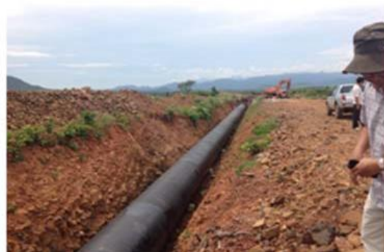
Hình 1.23 Thi công đường ống nhựa cốt sợi thủy tinh ở Kênh Thường Xuân thuộc hệ thống kênh Bắc Sông Chu - Nam Sông Mã, tỉnh Thanh Hóa
