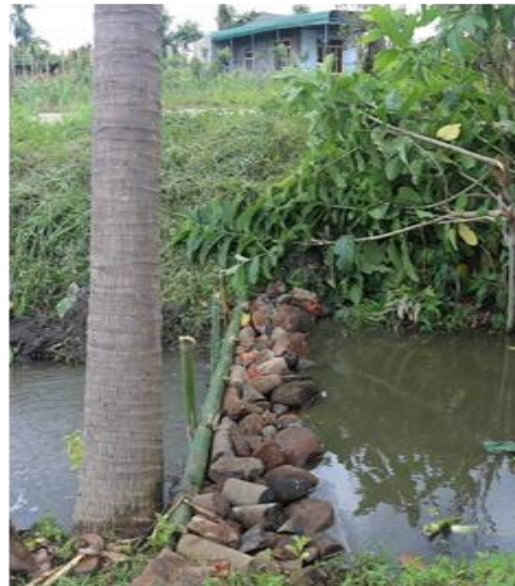
Hình 5.38. Check dam làm từ vật liệu tre và đá
