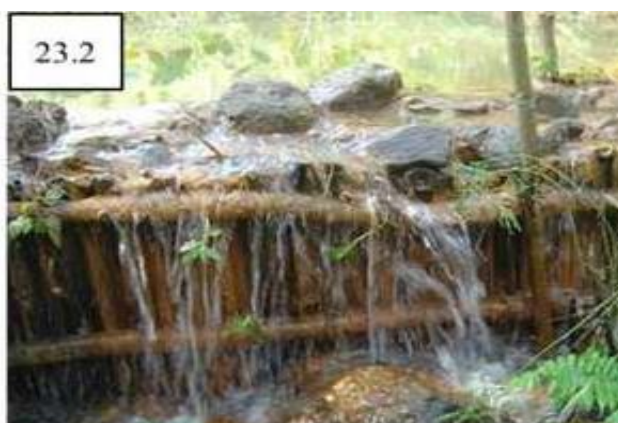
Hình 5.36. Check dam bằng vật liệu khung gỗ bọc túi cát hoặc bọc đá
