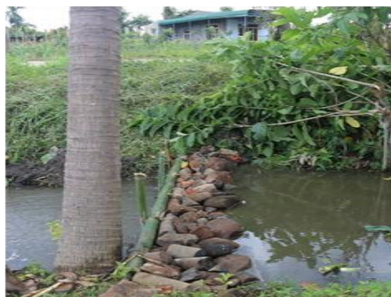
Check dam làm từ vật liệu tre và đá
