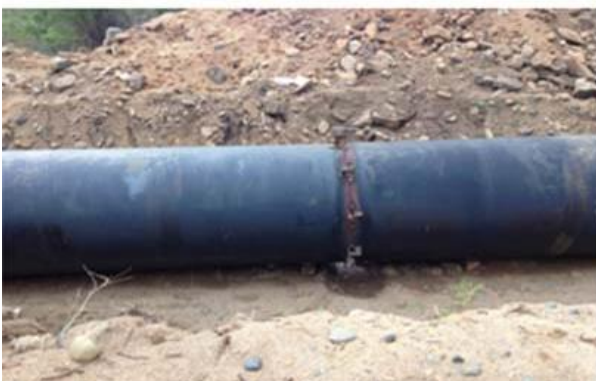
Hình 1.23 Thi công đường ống nhựa cốt sợi thủy tinh ở Kênh Thường Xuân thuộc hệ thống kênh Bắc Sông Chu - Nam Sông Mã, tỉnh Thanh Hóa
