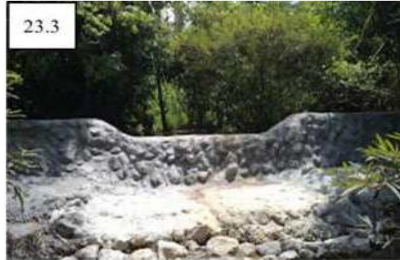
Check dam dùng vật liệu đá xếp; đá trát vữa
