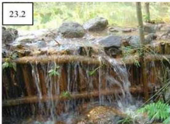
Check dam vật liệu khung gỗ bọc túi cát và khung gỗ bọc đá
