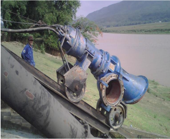
Hình 4.26 Máy bơm chìm di động trên ray nghiêng
