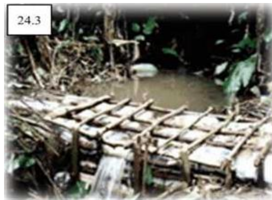
Check dam vật liệu khung gỗ bọc túi cát và khung gỗ bọc đá
