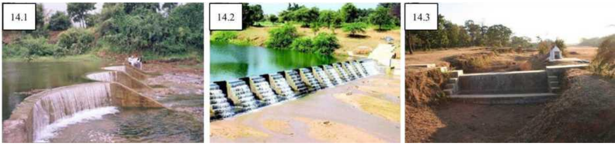
Hình 1.6 Mẫu Check Dam bằng bê tông ở Ấn Độ
