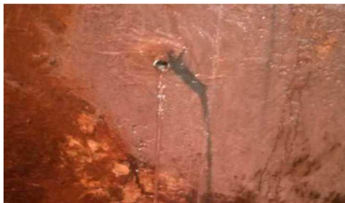
Hình 4.12. Chống thấm điểm thân cống
