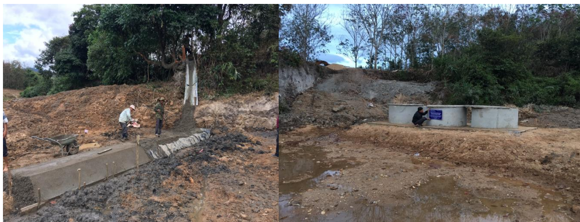
Đập ngầm được thi công
