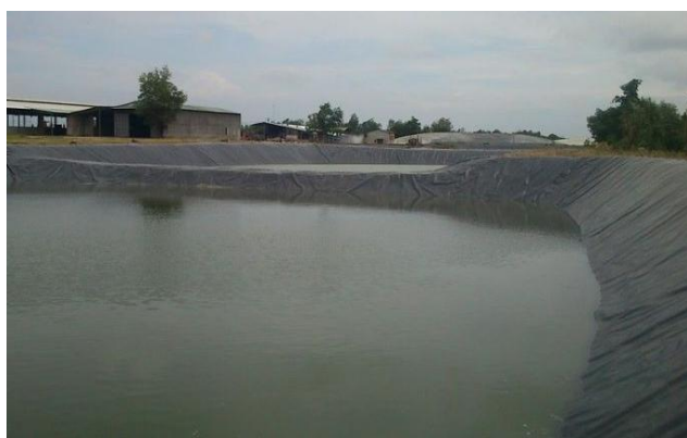
Hình 5.54. Trữ nước bằng bể HDPE
