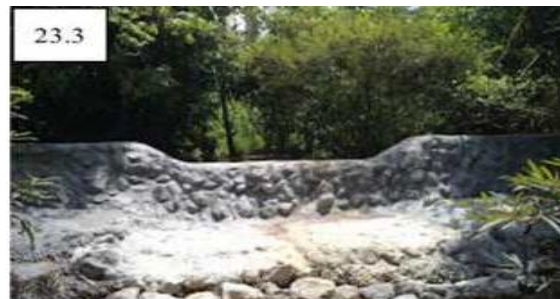
Hình 5.35. Check dam dùng vật liệu đá xếp; đá trát vữa
