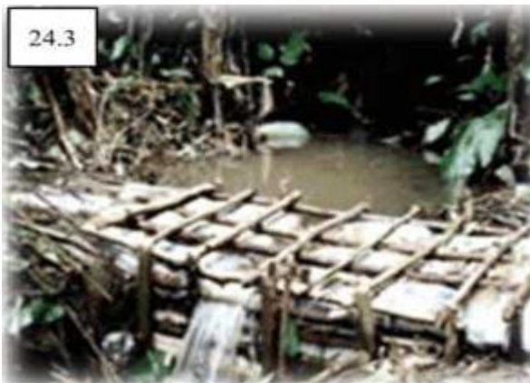
Hình 5.36. Check dam bằng vật liệu khung gỗ bọc túi cát hoặc bọc đá
