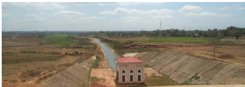
Hình 5.10 Đập và hệ thống kênh tưới dự án Krông Buk Hạ - huyện Krông Buk – Đắk Lắk
