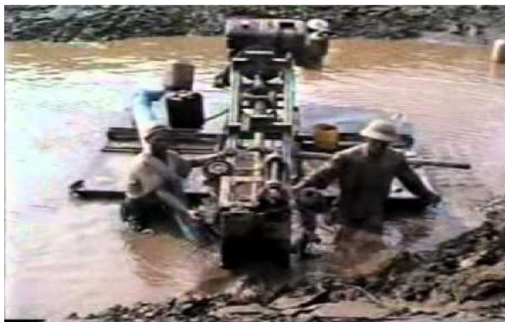
Hình 4.8 Nạo vét bùn cát bằng máy hút bùn
