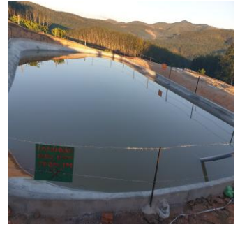
Bể chứa nước
