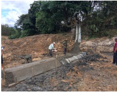
Thi công đập ngầm
