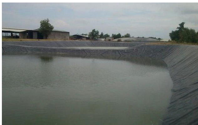
Trữ nước bằng bể HDPE
