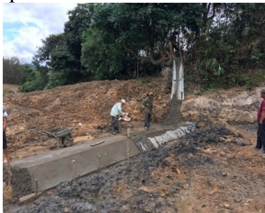
Thi công đập ngàm
