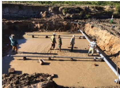
Thi công thiết bị thu nước
